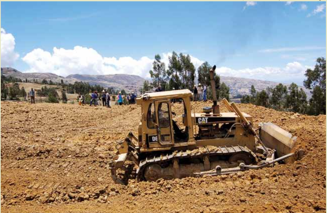
Conformación del dique con tractor oruga.
