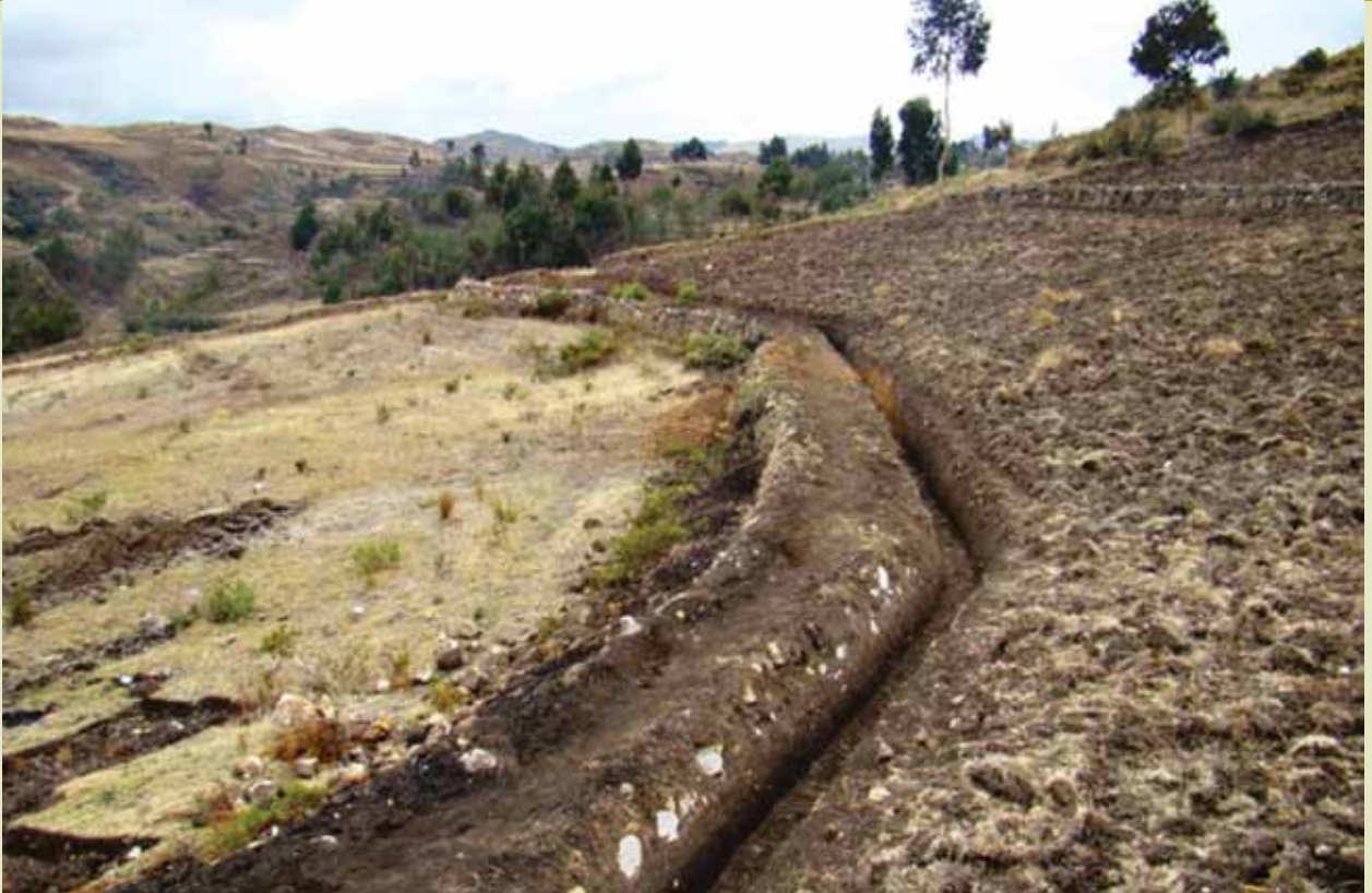
Canal de aducción.
