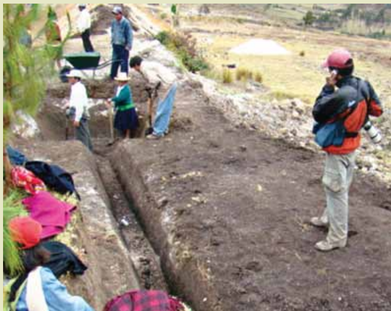
Construcción de canal de aducción y desarenador, caserío de Calvario.
