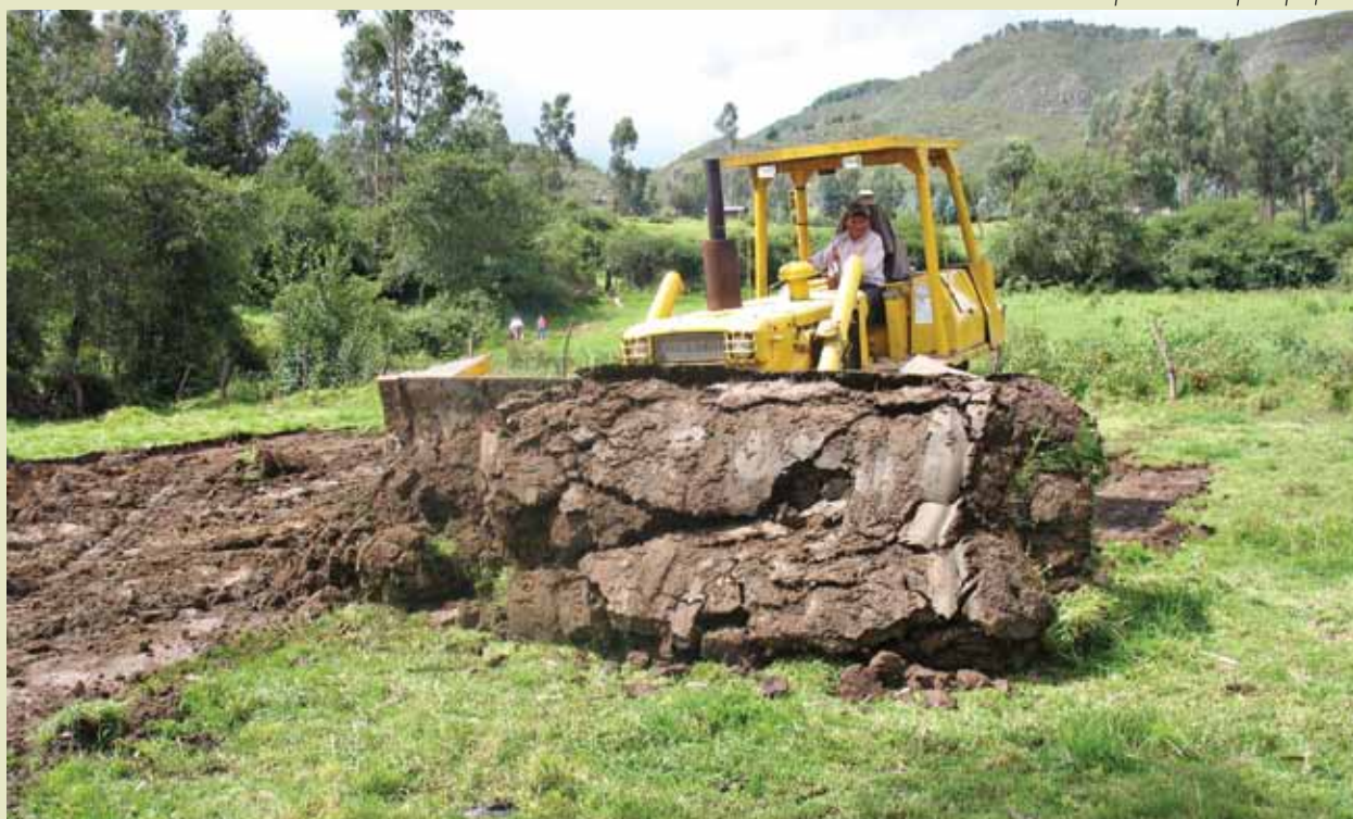
Limpeza de la capa superficial.
